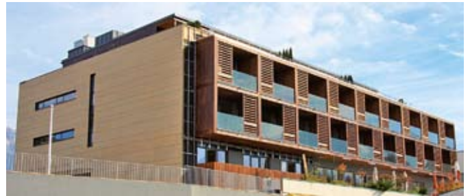
Der neue Teil des Ritzenhofes mit unterirdischem Wellness Bereich.
